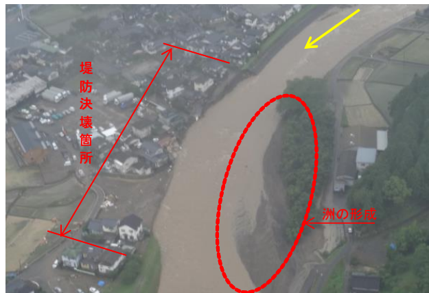
写真-3 花月川6k200付近堤防決壊状況(7月3日)
