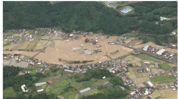
写真-1 花月川8k000付近堤防決壊状況(7月3日)
