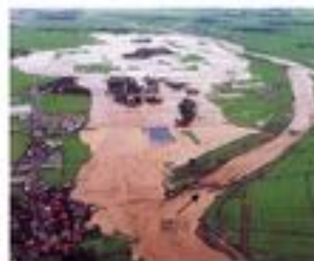
堤防決壊状況（砂高市月間地先）
