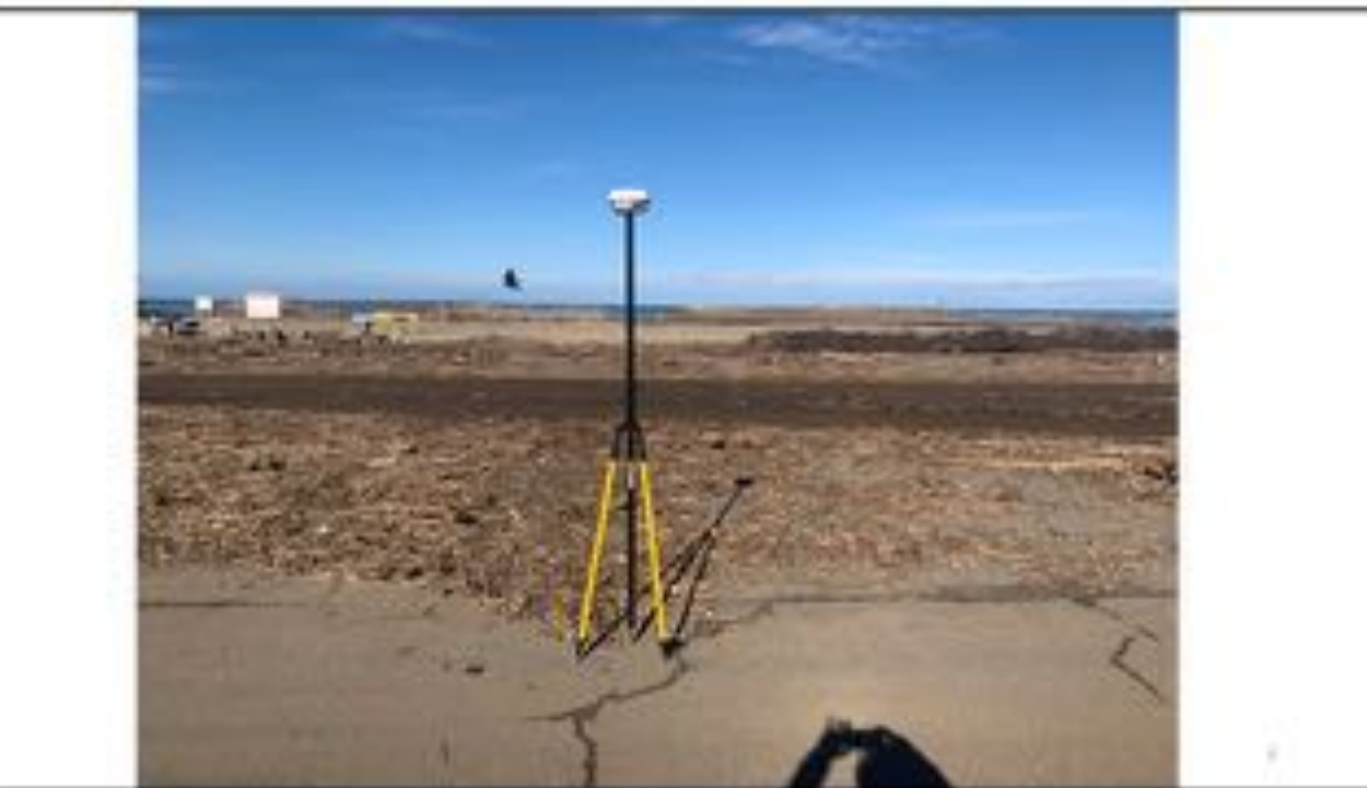
船見公園の北東端の駐車場。明確な痕跡ライン。濃い茶色はブルドーザーの清掃が入った直後のあと。
