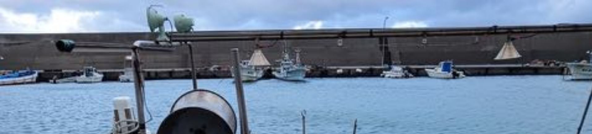
■入善魚港・二重越波堤
