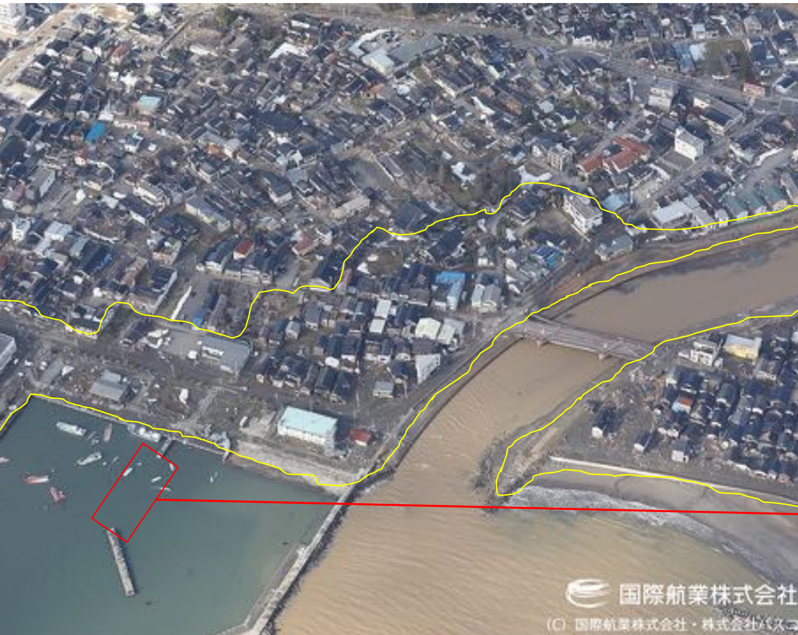
防波堤の被害
