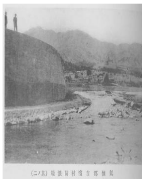
写真4 吉浜防浪堤 その2
