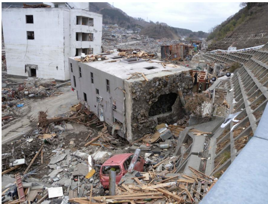
写真8 転倒した鉄筋コンクリート造ビル（藤間氏提供）
