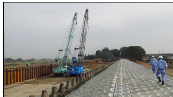
写真-4 堤防決壊箇所の応急復旧完了状況
