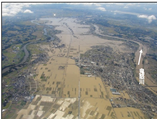
写真-1 茨城県常総市三坂町の氾濫状況
